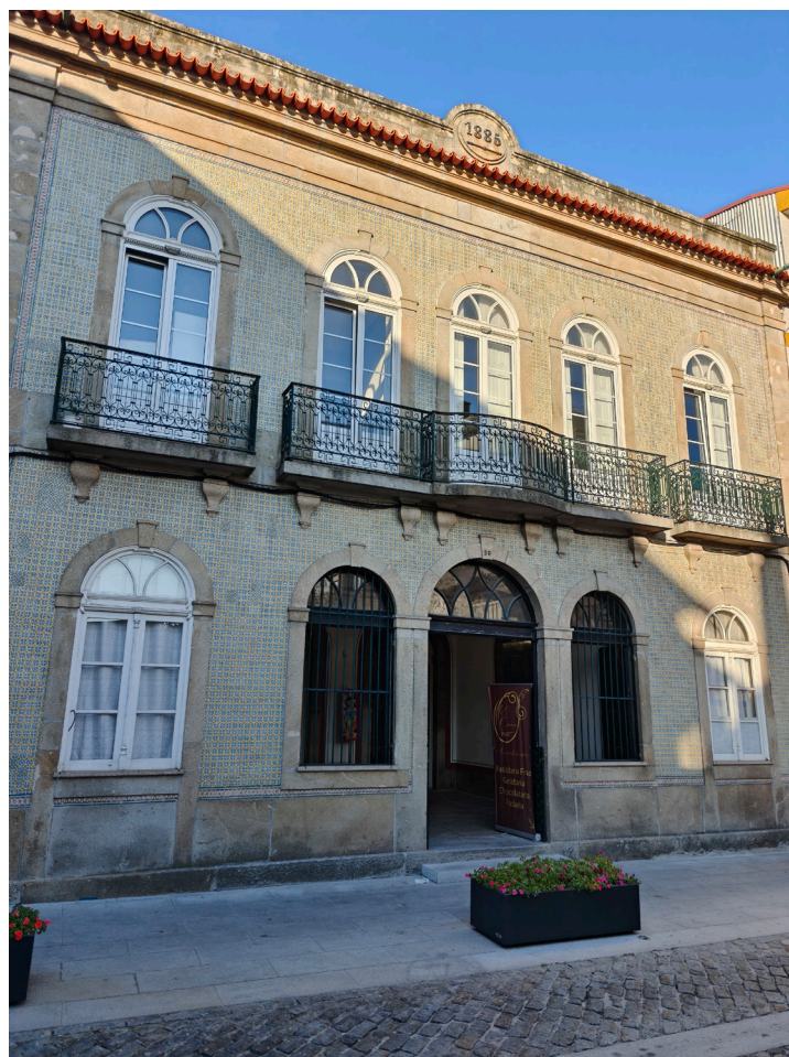
Figura 5. Edifício na rua Monsenhor Vieira de Castro, 58. Localização: https://goo.gl/maps/wBHnBKLv3FRWaBun6
