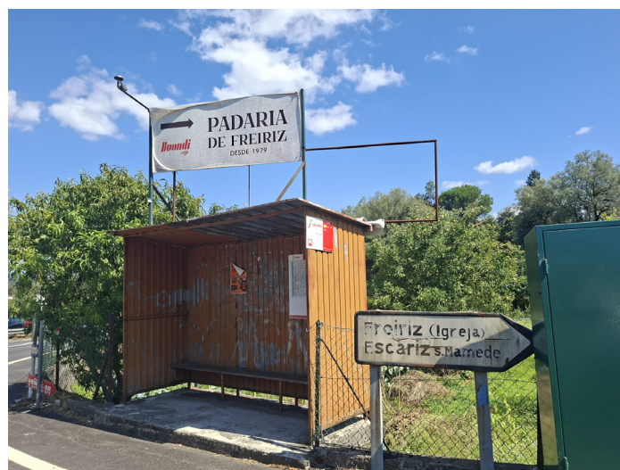
Figura 3. A paragem em chapa metálica (Carreiras — S. Miguel, Vila Verde)
